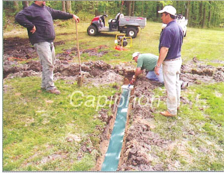
◀ 工事前、水溜りがあちこちにある。
