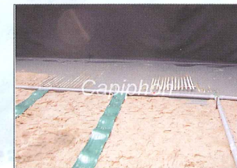
◀ (台湾) 排水シートを使用したケアフォー量販店の建築物の基礎浮き上げ防止工事の施工実況。
