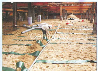
◀ (台湾) 排水シートを使用したケアフォー量販店の建築物の基礎浮き上げ防止工事の施工実況。
