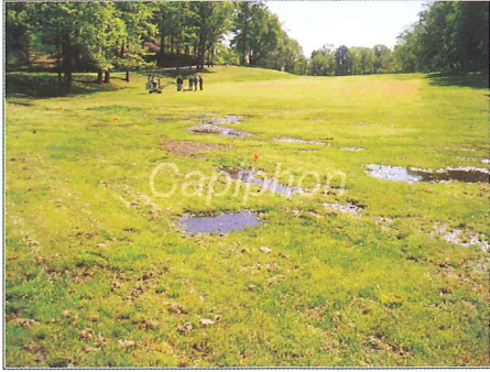
◀ (米国) GIBSON ILANDのゴルフ場の排水工事施工実況
