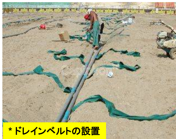
* ドレインベルト込み排水管を設置
