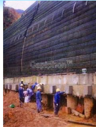
* 地下水で壁が変形した
