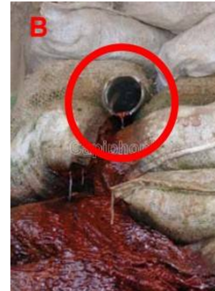
B:ドレインベルト込み排水管、排水状況は特に変化なし
