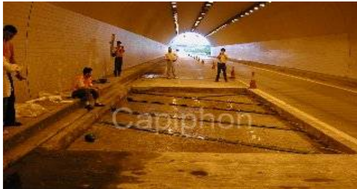
*トンネル内の地下水漏れ、 ドレインベルトを設置
