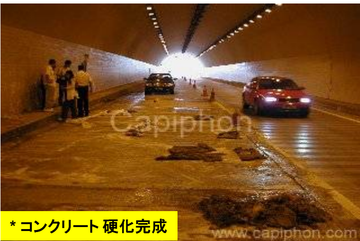
*トンネル内の地下水漏れ、 ドレインベルトを設置
