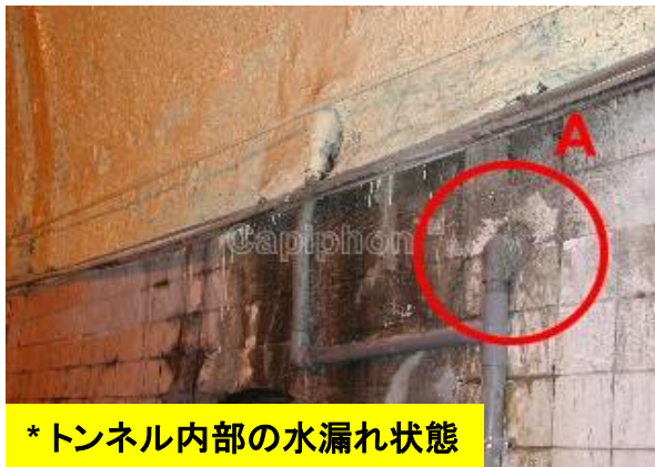
* 配管を設置して集水する
