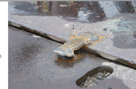
従来の切り板の溶接による連結はバタツキが生じます。
