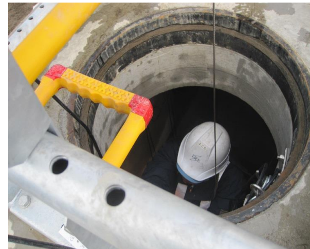
2017/11/22 石狩新港発電所建設工事(発注先:北海道電力)
